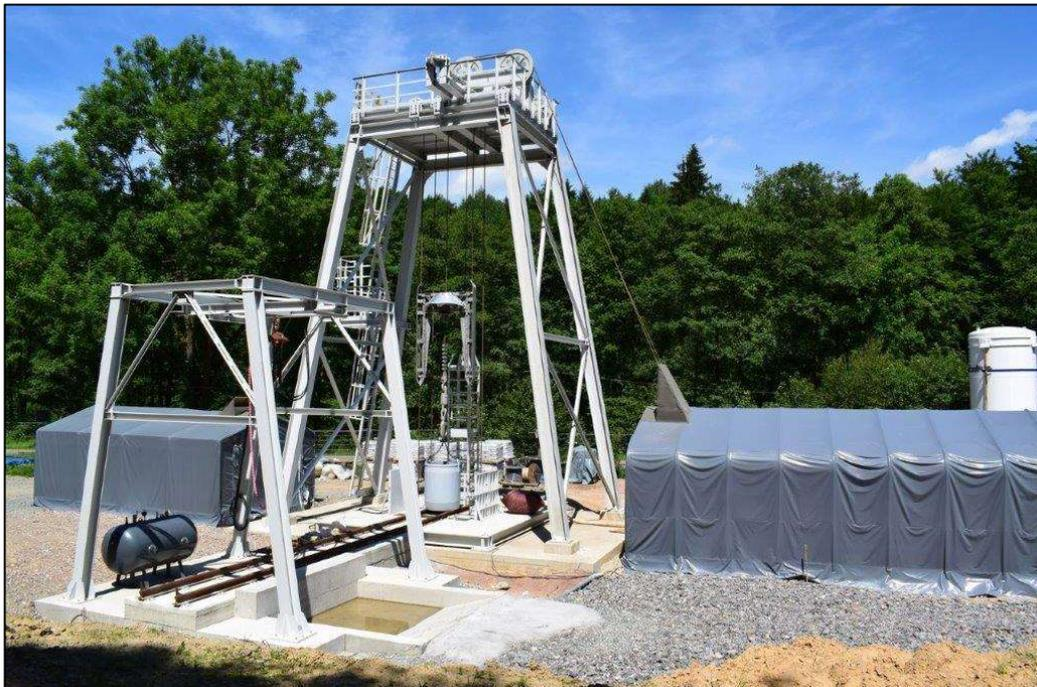
Abbildung 4: Teufanlage Schurfschacht Pöhla (©: SME)
