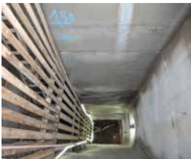
Das Foto zeigt die Bewehrungseisen für die Schachtplombe am Schurf 1 kurz vor dem Einbringen des Betons. Die Schachtröhre steht im festen Gebirge und ist noch bis ca. 2 m unter der Tagesoberfläche mit Masse verfüllt.
