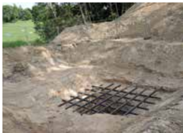
Das Foto zeigt die Bewehrungseisen für die Schachtplombe am Schurf 1 kurz vor dem Einbringen des Betons. Die Schachtröhre steht im festen Gebirge und ist noch bis ca. 2 m unter der Tagesoberfläche mit Masse verfüllt.
