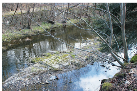
Ein Fundament für einen Brückenpfeiler ist bei Niedrigwasser im Schwarzwasser noch zu erkennen.
