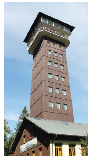
Baustellen mit diesem Rundblick sind auch für Industriekletterer nicht alltäglich.
