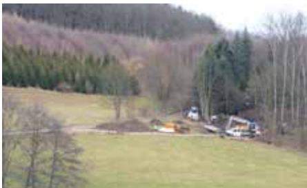
Bild 1: Baustelle Schurf 2 im Ortsteil Lauter
