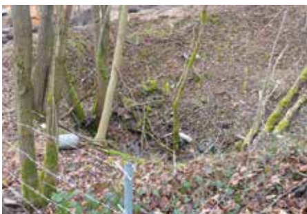
Bild 2: Eingebrochener Schurf 2 im Ortsteil Lauter
