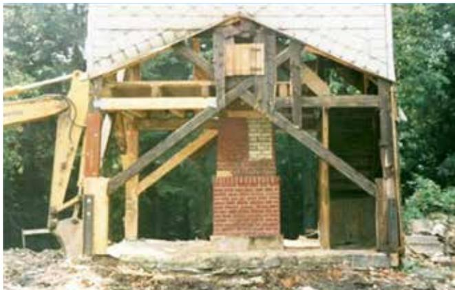
Im Juni 1998 begannen die Arbeiten an der Morgenleithe mit dem Abriss des alten Gebäudes. Der Turmfuß wurde mit einem Stahlrahmen gesichert. Am 5. November 1998 konnte das Richtfest gefeiert werden. Der Turm konnte witterungsbedingt erst im März 1999 eingerüstet und neu verkleidet werden. Auch das Dach und die Fenster wurden erneuert.
