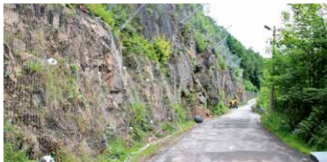
Die neue Felssicherung auf einem Foto vom 2. September 2015.
