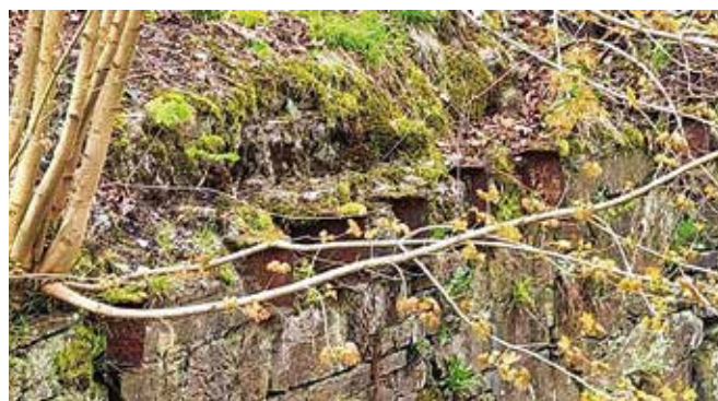
Detail des alten Widerlagers auf Lauterer Seite. Die für die erste Brücke verwendeten sieben Doppel-T-Träger sind noch gut zu erkennen.
