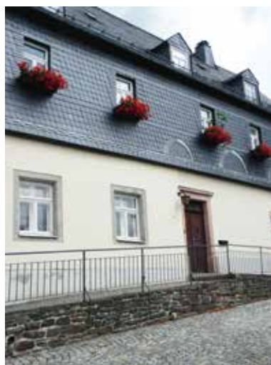
Pfarrhaus Bernsbach mit Türgewände von Chemnitzer Porphyrtuff (Zeisigwald) und Fenstergewände von Auer Granit, anspruchsvolle Schieferverkleidung
